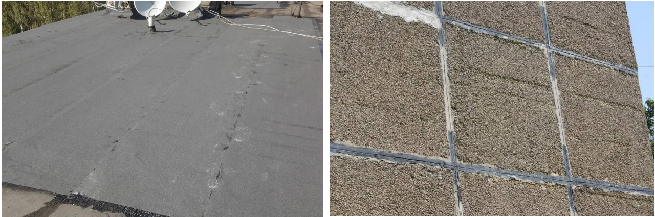
Рис. 8. Ремонт покрівель та міжпанельних швів багатоквартирних будинків
