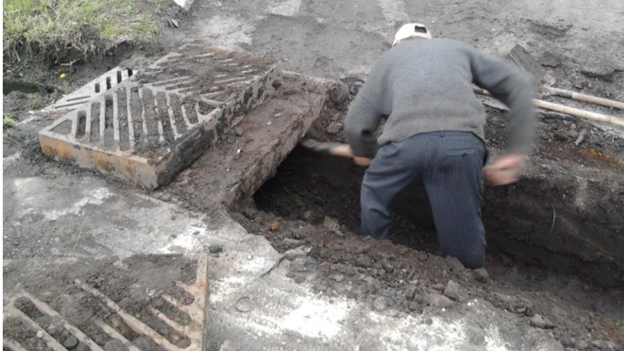
Рис. 14. Очищення мережі зливової каналізації.
