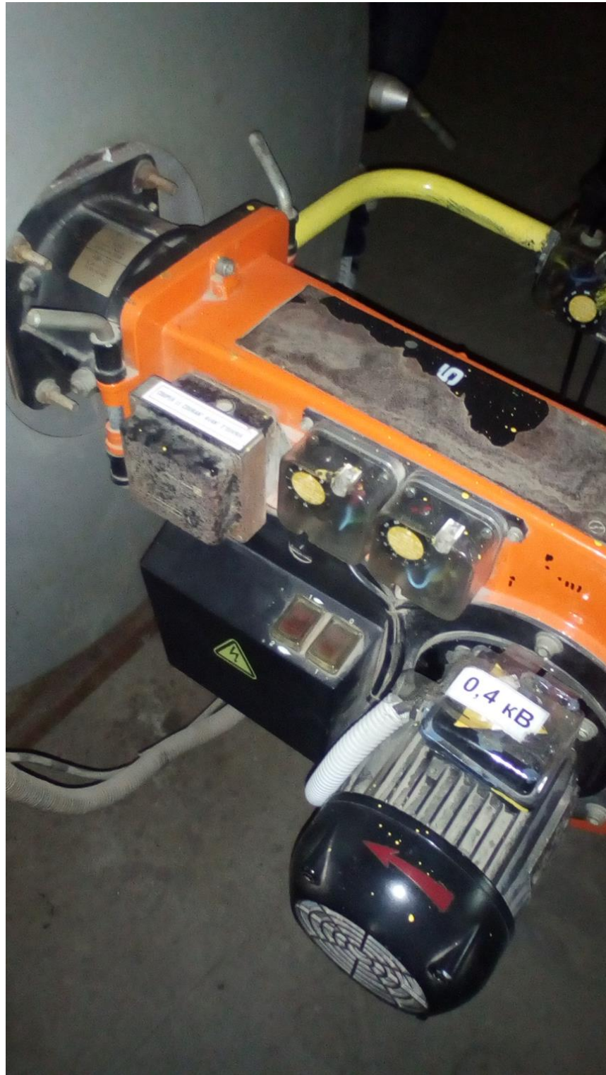
Рис. 10 - Горелочное устройство котла «МИНА»
