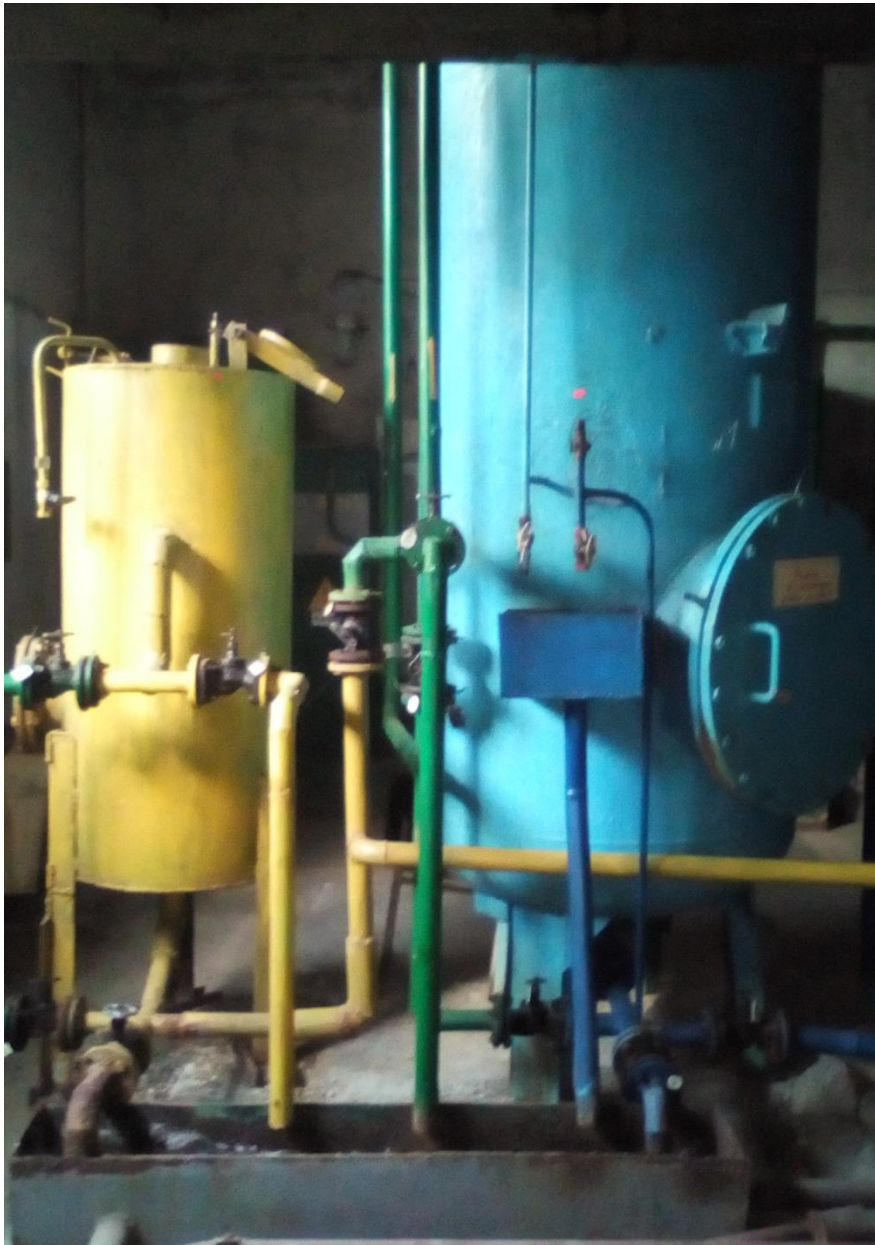
Рис. 9 - Система водоочистки с натрий- катионитовым ионообменным фильтром.
