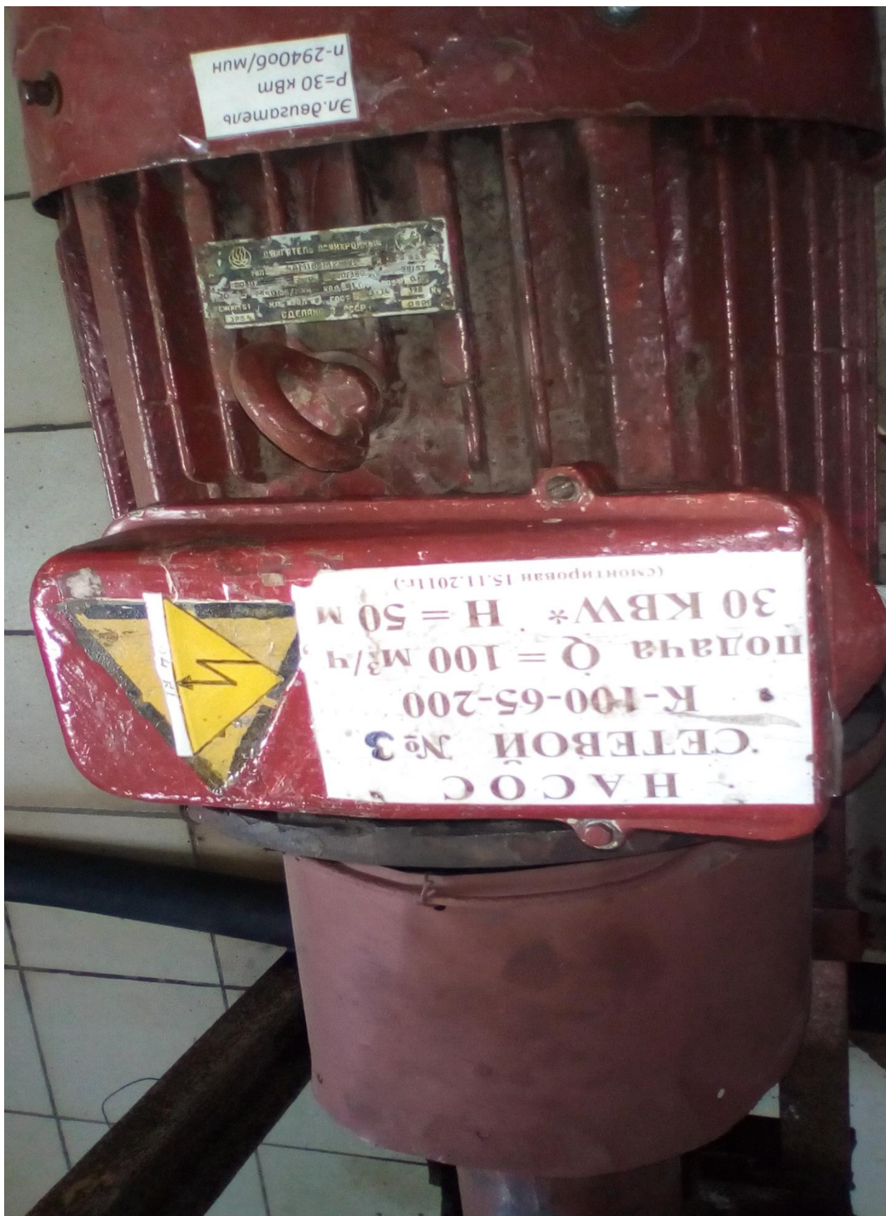
Рис. 4 – несоответствие характеристик привода
